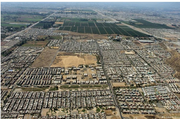
Bajos de Mena, Puente Alto
